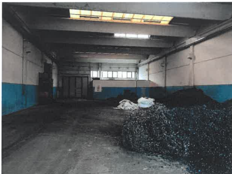
Interno del Capannone
