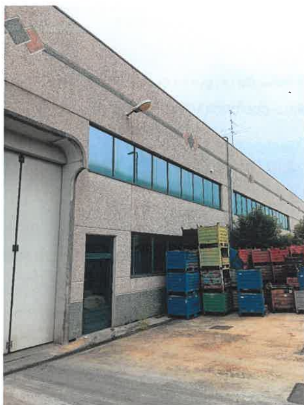
Facciata Ovest Corte Via Monticella
